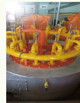
부산도시가스 초저녹스 버너 설치
